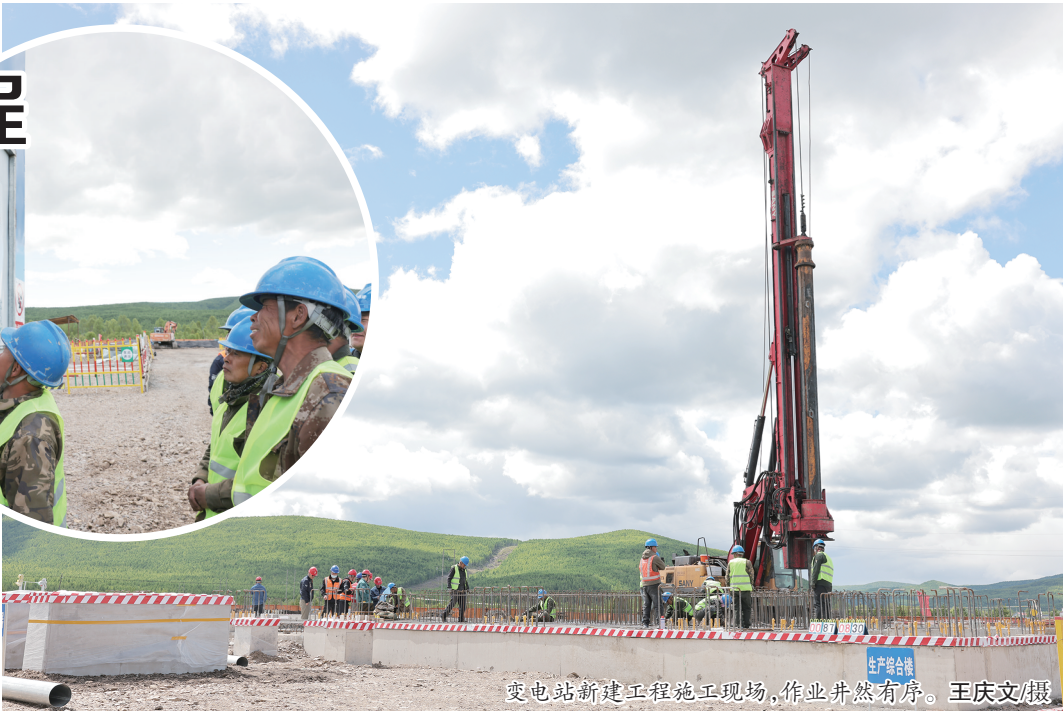
变电站新建工程施工现场，作业井然有序。王庆文/摄
