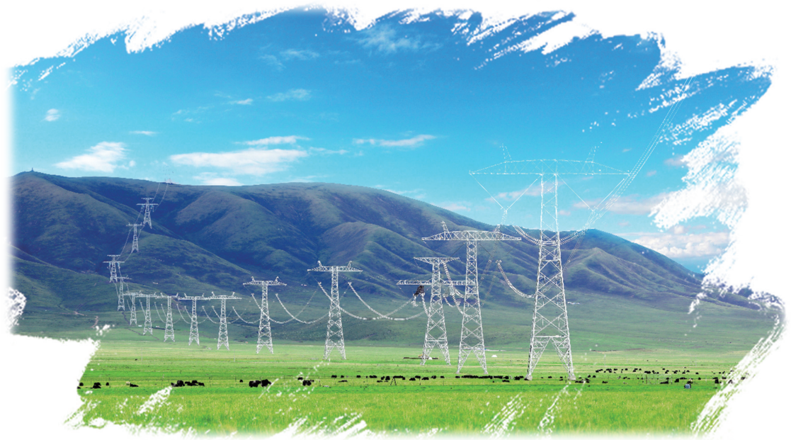
图为青海至河南±800千伏特高压直流工程输电线路大通道。谢莉蓉/摄
