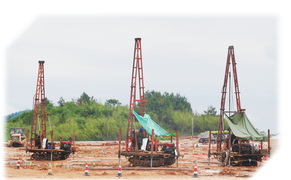
湘黔背靠背换流站工程施工现场。韩旭/摄
