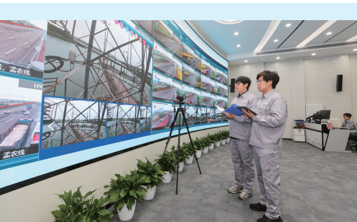
▲国网天津电缆公司工作人员24小时值守高压电缆智能管控平台。 ▲机械狗在地下电缆隧道开展测温 and 局放检测工作。
