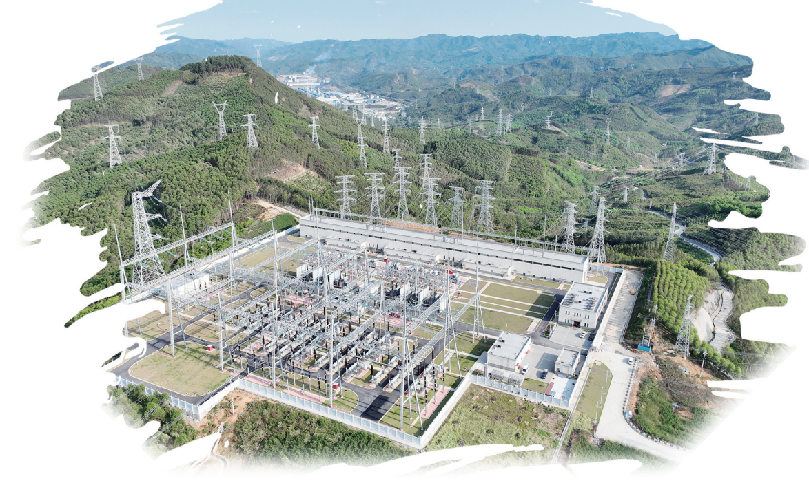
500千伏蓝田变电站配套线路工程赋能革命老区发展。黄一浩/摄
