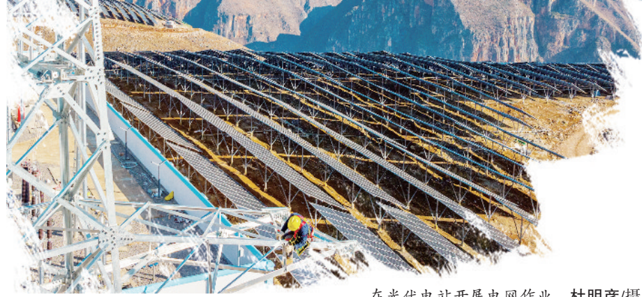
在光伏电站开展电网作业。杜明彦/摄
