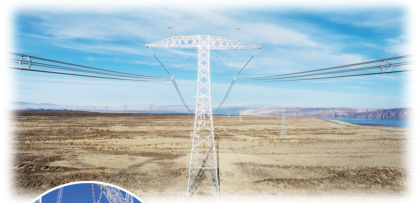
青海—河南±800千伏特高压直流输电线路(青海段)。王国栋/摄
