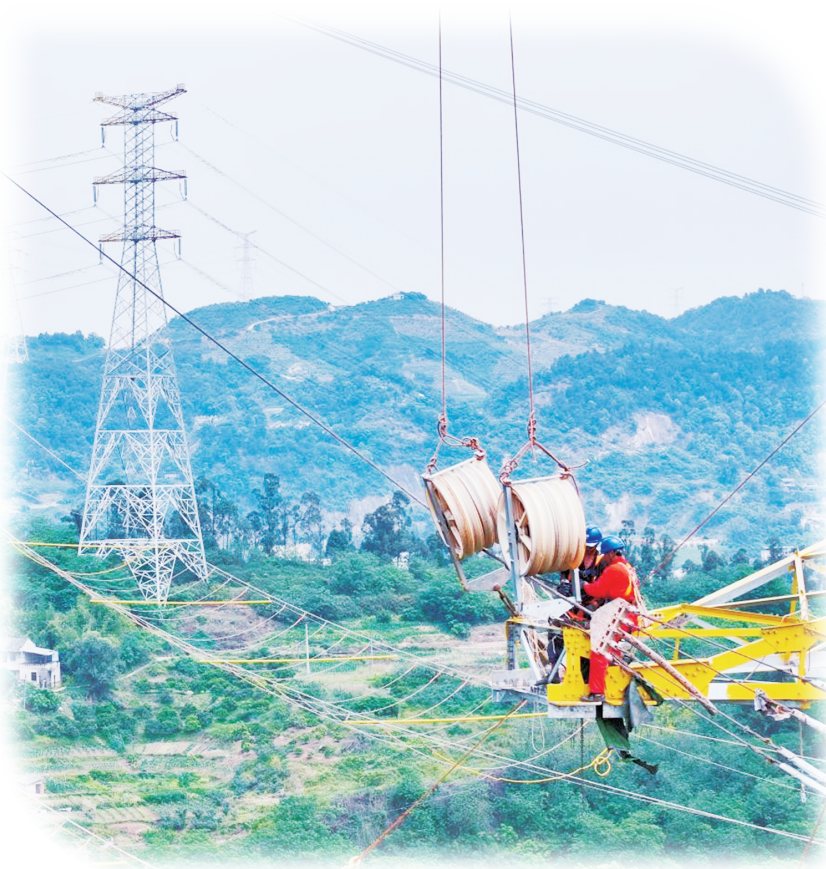
重庆送变电公司员工在500千伏新玉—圣泉线N2018号塔—N2021号塔放线段调整滑车角度。陈明月/摄
