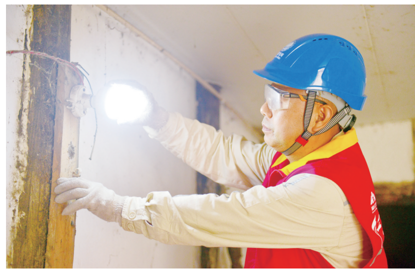
国网重庆市北供电公司志愿者入户检查孤寡老人杨义维家中线路开关。 冯胜岚/摄
