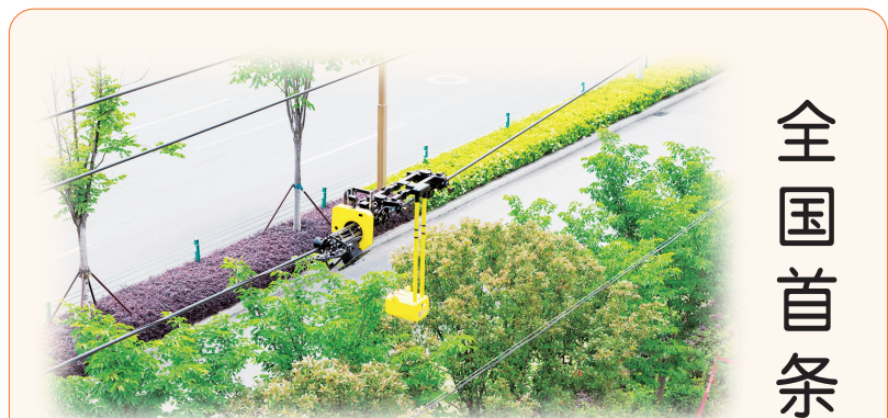
光缆缠绕机器人在浙江嘉善10千伏东云线开展全自主作业。 李前蕾/摄
