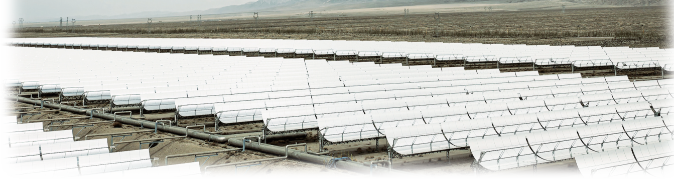
图为中广核德令哈50兆瓦槽式光热发电示范电站。朱学蕊/摄
