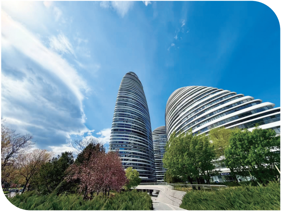
图为北京市朝阳区望京SOHO。本报记者 焦翔/摄
