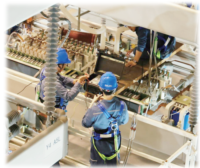
南网超高压公司广州局运维人员对网塔设备进行检测。 南网超高压公司/供图
