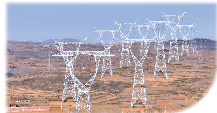
山东加快推进烟威、海阳辛亥核电送出特高压工程建设。 侯伟/摄
