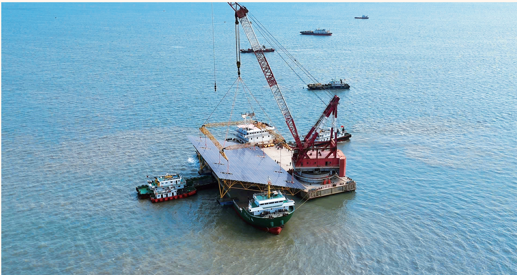
图为位于田横湾的中电建青岛即墨海上光伏项目吊装现场。杨文昌/摄
