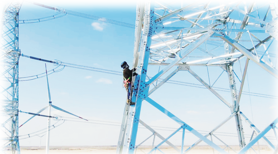
国网通辽供电公司工作人员在国家第二批大型新能源基地500千伏送出工程现场进行架线作业。李东/摄
