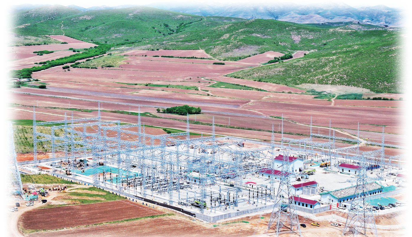
桃合木500千伏新能源汇集输电工程。柏松/摄
