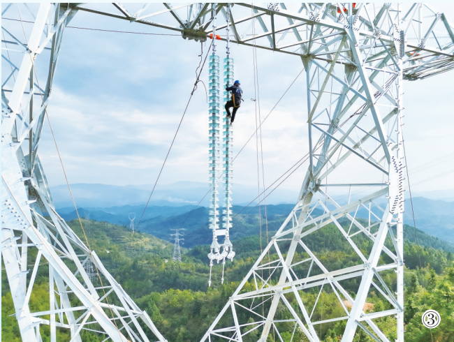
图①为南方电网超高压公司开展500千伏黎桂甲线13#、14#杆塔组装工作。
