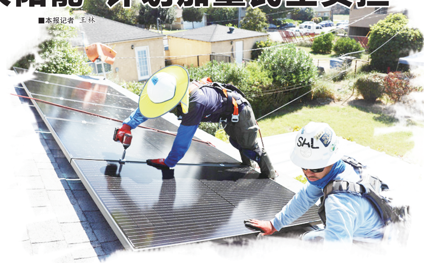
图为美国加利福尼亚的工人正在安装屋顶光伏板。
