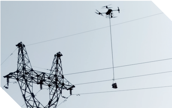
图为1月9日,南方电网广西柳州供电局工作人员运用无人机开展输电线路防冰涂料绝缘喷涂工作。 吴黎彬/摄
