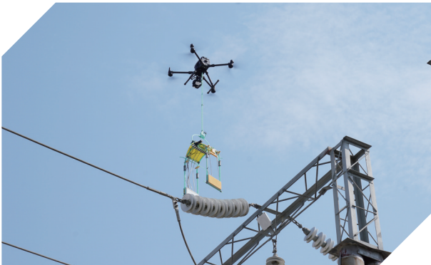
图为4月17日,广西电网首次应用“无人机+机器人”对绝缘子开展带电检测。 黄一浩/摄
