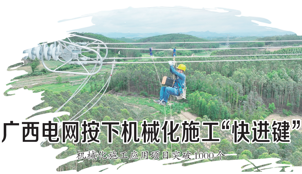
图为广西电网利用电动垂直起降飞行器开展抽水蓄能500千伏线路验收。 陈伯鑫/摄
