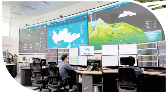
上图为惠州抽水蓄能电站上水库。 左图为位于广州的我国首个抽水蓄能多厂站集控中心,单名值班员的设备控制规模达到240万千瓦。
