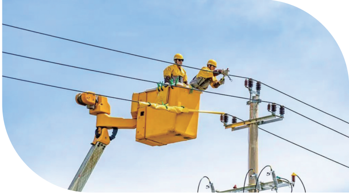
图为6月18日,国网衢州供电公司带电作业人员在柯城区妙龄岗附近开展带电接引流线工作。吴文涛/摄
