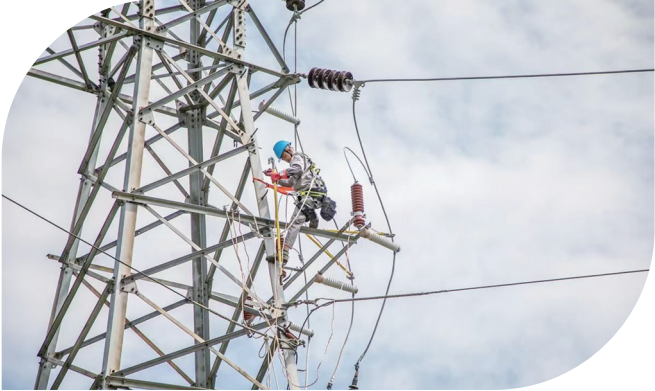
图为6月26日,国网临海市供电公司运维人员邹恩礼在35千伏巨洋线38号塔开展电缆头发热消除。朱露/摄
