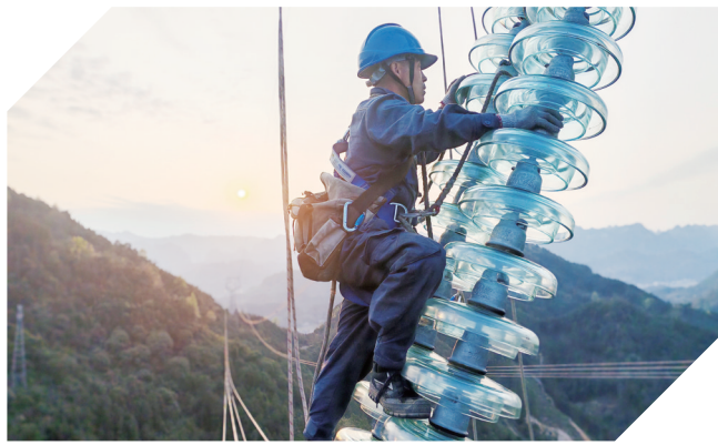
3月底,南网超高压公司柳州局员工完成500千伏龙风甲线年度检修工作,该线承担着广西龙滩水电站送出电力的重要任务。图为工作人员在进行绝缘子清扫作业。 蓝健育/摄
