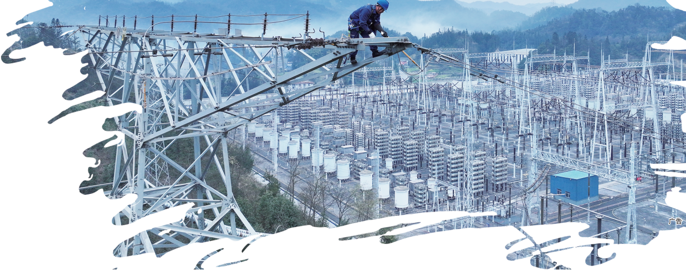
在2025年年度检修中,南网超高压公司曲靖局检修人员装设±500千伏牛从直流乙线1号塔地线永久接地线。 戴永平/摄
