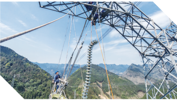
3月底,在广西河池500千伏龙风甲线,南网超高压公司柳州局员工首次开展直线转角塔绝缘子单改双工作。 蓝健育/摄
