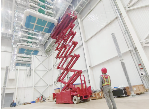
国网湖南电力工作人员在衡阳±800千伏换流站工程极2高端阀厅开展阀塔螺栓紧固工作。邓思凡/摄
