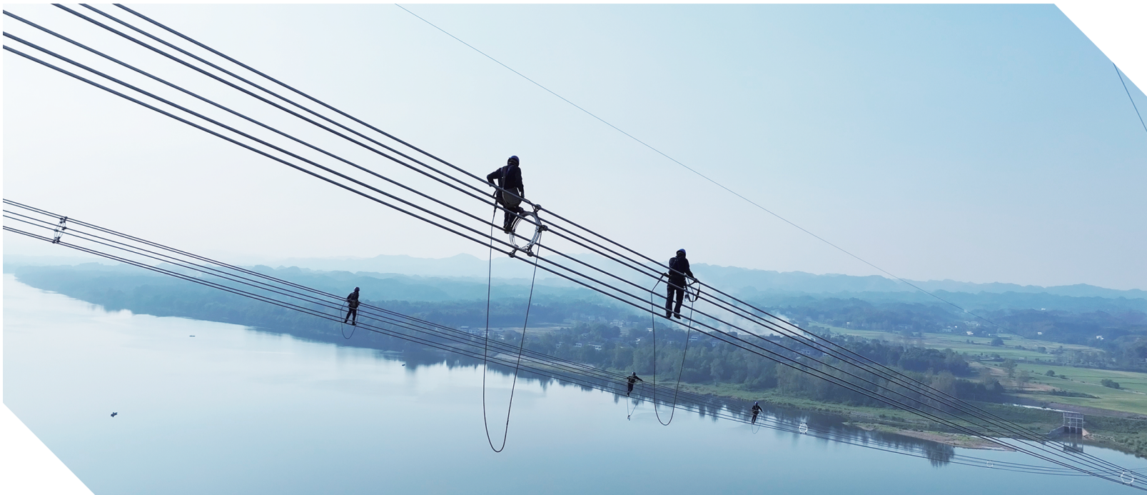
宁夏—湖南±800千伏特高压直流输电工程(湘2标)在跨越沅江处开展附件安装作业。邹勋/摄
