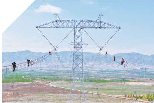
宁夏中卫市沙坡头区宣和镇境内,电力工人正在宁夏至湖南±800千伏特高压直流输电工程宁夏段开展高空走线验收。袁宏彦/摄
