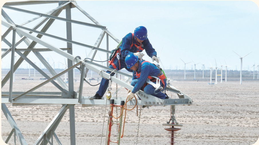
图为甘肃酒泉供电公司输电运检工作人员在330千伏31472玉清I线开展更换绝缘子工作。 王娜/摄
