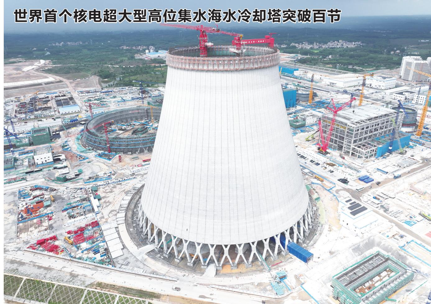
6月2日,广东廉江核电项目1号机组冷却塔筒壁第100节混凝土浇筑顺利完成,塔体高度达到161米,标志着冷却塔主体结构稳步成型,为后续双曲线收束段施工奠定了坚实基础。廉江核电项目在我国核能领域首次开发使用超大型冷却塔,1号机组冷却塔是世界首个核电超大型高位集水海水冷却塔。
