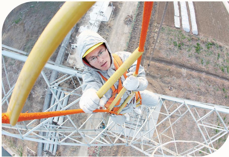
暮春的齐鲁大地,地表温度已超30摄氏度。在百米高空,一人身穿银色屏蔽服,灵活穿梭于输电导线间。安全帽檐下,汗珠接连滚落。国网山东超高压公司输电运维三班班长李敏正开展带电作业。
