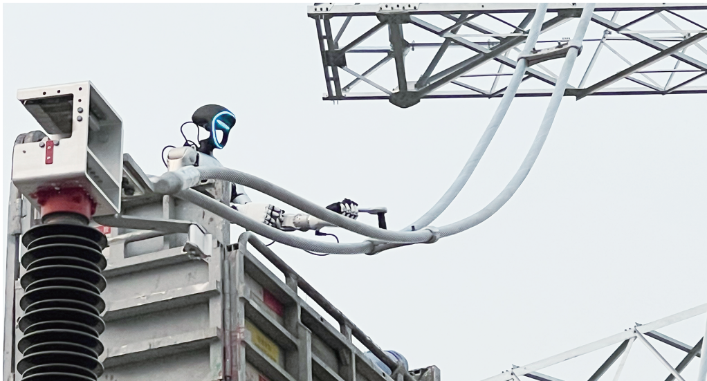
图为入形机器人开展220千伏吉能线引流线螺栓紧固作业。
