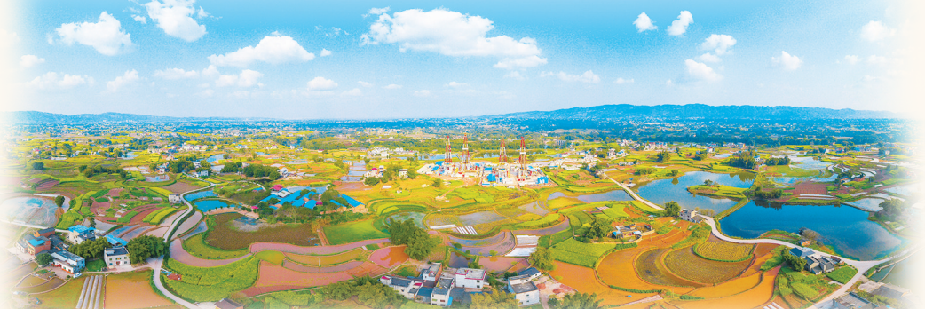
图为西南油气田泸203H6平台。
