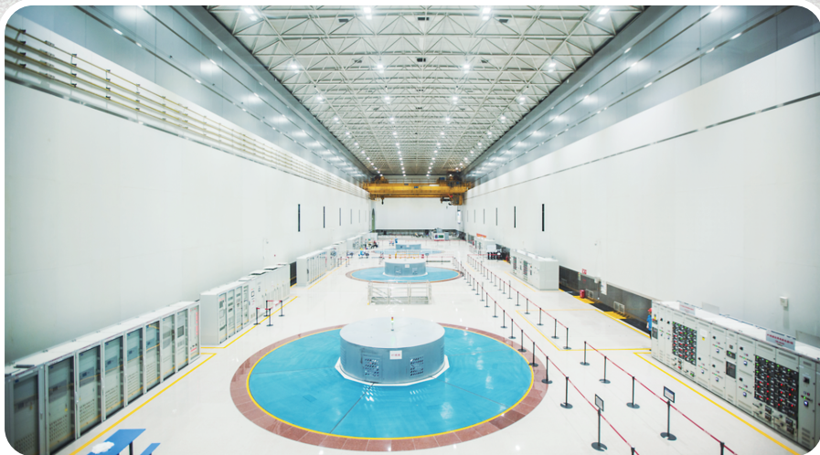
2024年,为保障光伏等新能源的日间大规模并网,海南抽蓄运行模式由“夜间抽水”调整为“白天抽水”。图为海南琼中抽水蓄能电站地下厂房。
