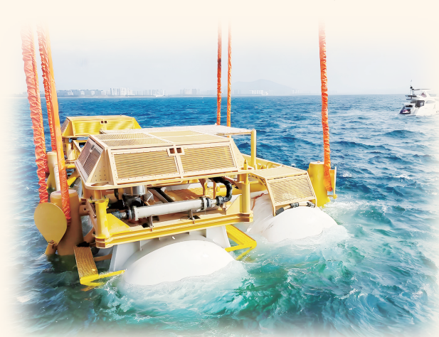
2月18日,一个新的数据舱在海南陵水近海海域被放入海底。海底数智中心/供图
