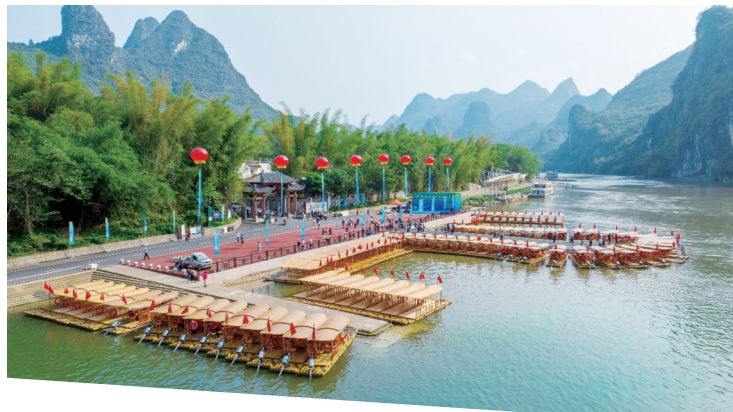
图为南方电网广西电网公司在桂林杨堤码头及兴坪大河背码头投资建设两座电动排筏充电站，为电动排筏提供充电服务。廖嘉琦/摄
