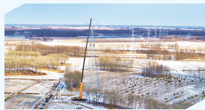
华能阜新彰武50万千瓦光伏治沙示范项目220千伏送出工程铁塔组立现场。魏晓丽/摄
