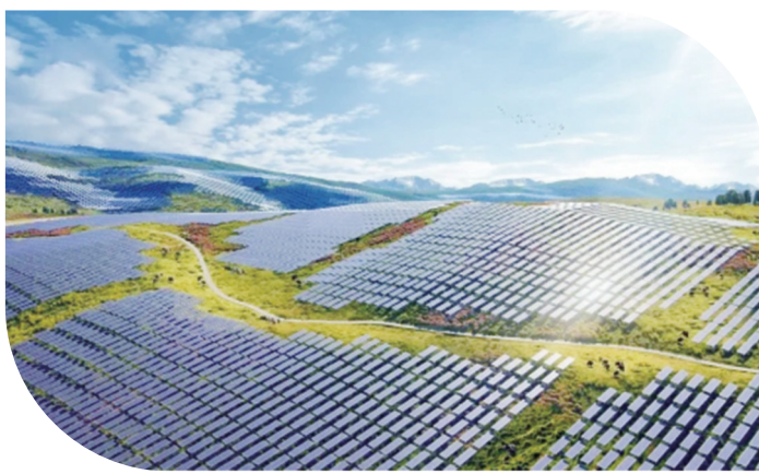
雅砻江流域水风光一体化基地柯拉光伏电站项目
