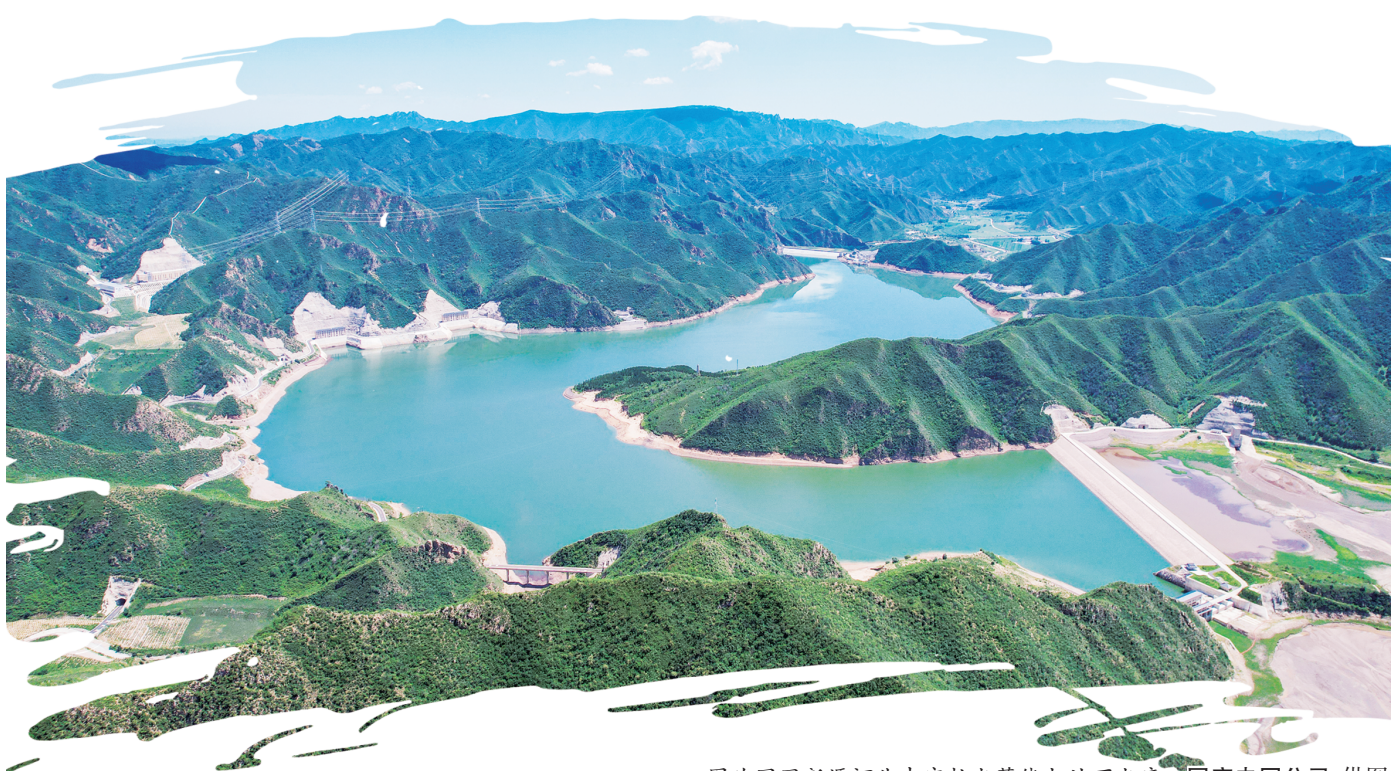
图为国网新能源河北丰宁抽水蓄能电站下水库。国家电网公司/供图
