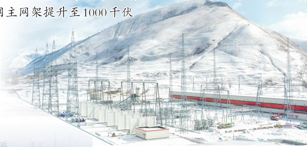
图为海拔3450米的川渝特高压工程四川甘孜1000千伏变电站,汇集甘孜地区水、风、光清洁能源送往成渝负荷中心。赖俊吉/摄
