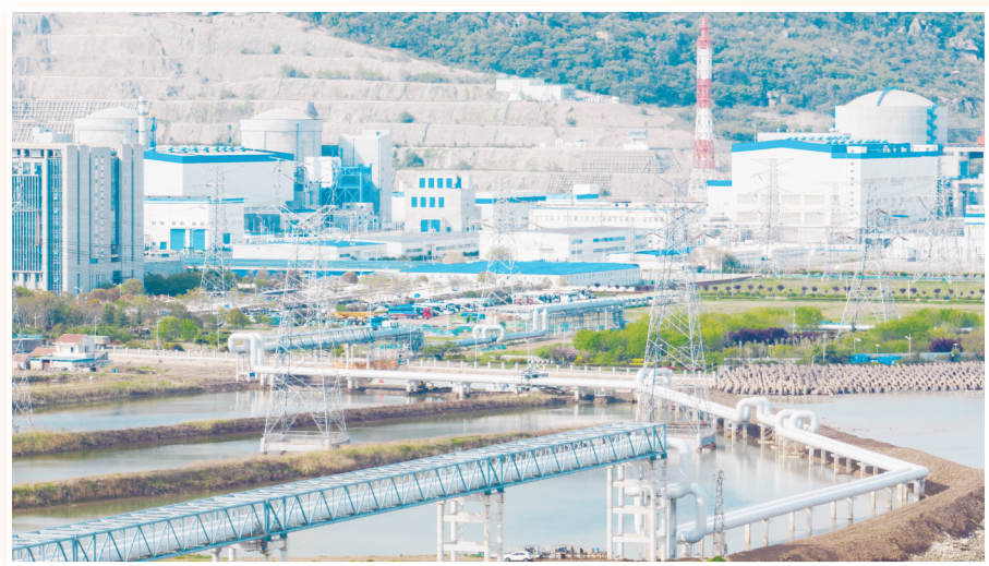
图为我国首个工业用途核能供汽项目“和气一号”蒸汽输送管道。田湾核电/供图
