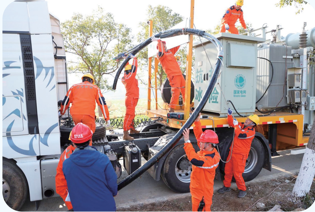
图为江西送变电公司演练作业人员开展融冰车电缆连接作业。钟家斌/摄
