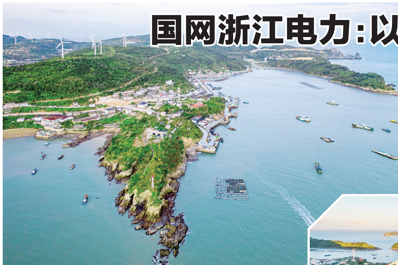
浙江台州大陈岛上的风力发电场 曹琼蕾/摄
