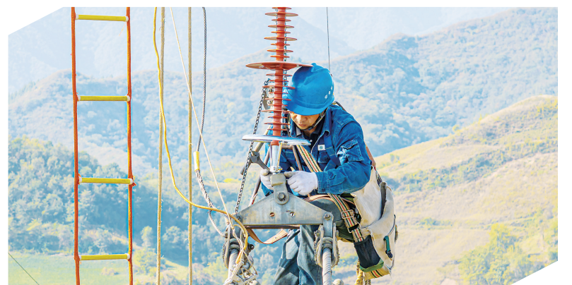
图为国网河南电力工作人员开展防覆冰绝缘子更换工作，补强线路度冬抗冰能力。张果峰/摄
