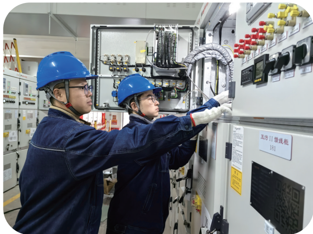
国网陕西电力员工在开展配电装置技改更换工作。
