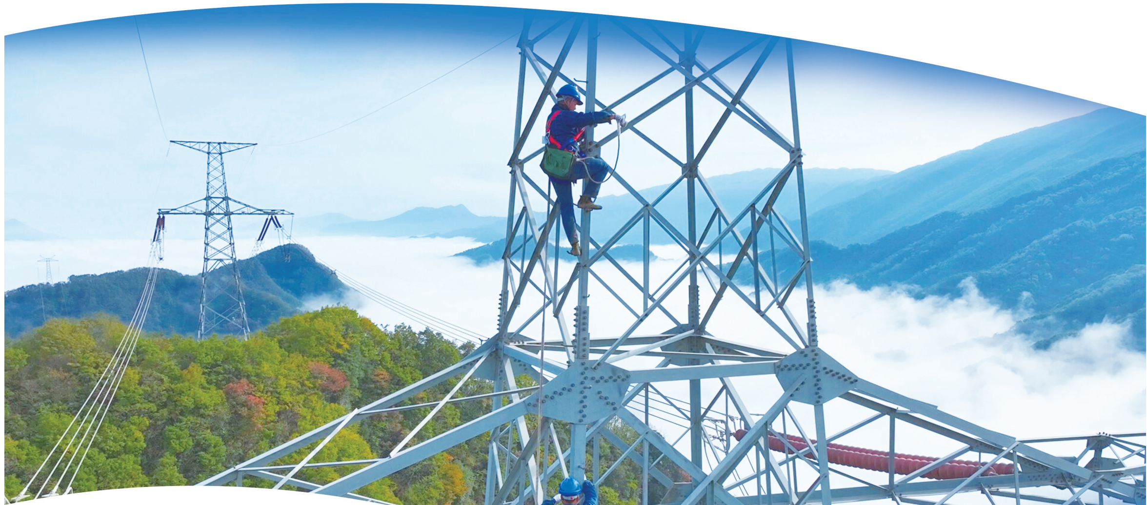
国网陕西电力员工开展线路检修作业。
