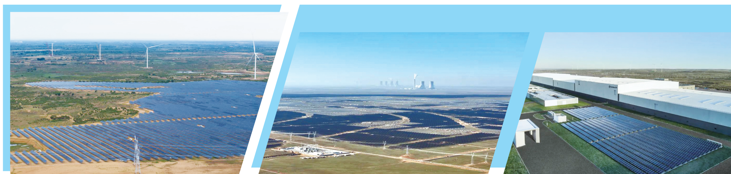
图为内蒙古能源抗锦风光火储生态治理项目光伏区。
