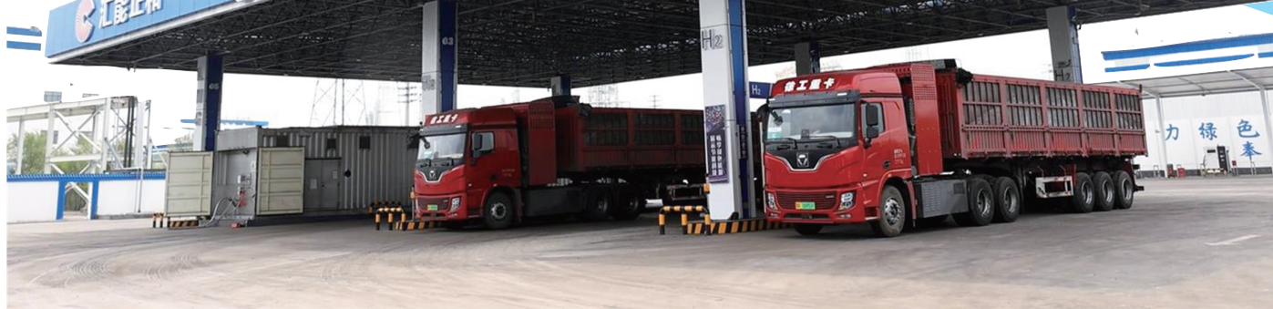
图为内蒙古汇能正和新能源有限公司加氢加气(LNG)一体站。
