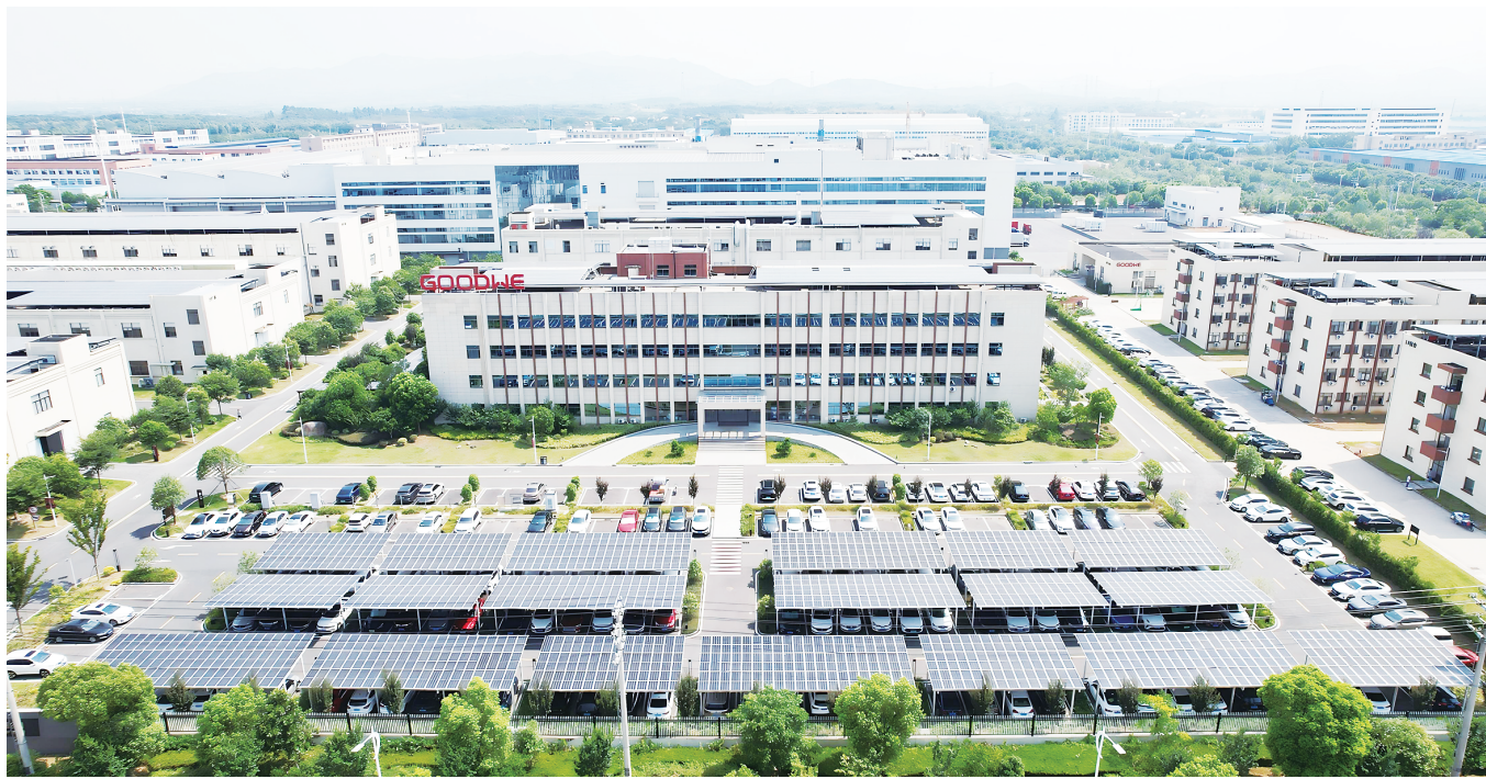
固德威安徽广德零碳产业园区
