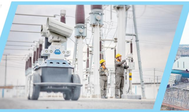
图为内蒙古电力集团鄂尔多斯供电公司利用智能化设备开展变电站巡检工作,确保能源输出畅通。
