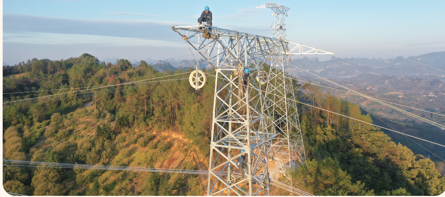
图为施工人员对新建的500千伏漓渚甲线进行放线工作。彭朋/摄
