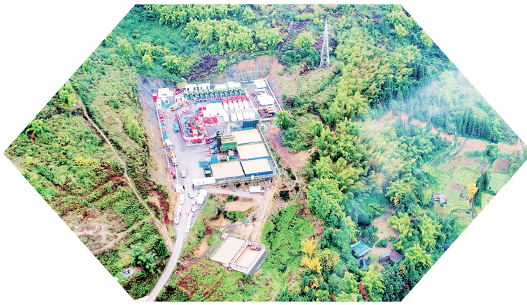
中国石化涪陵页岩气田阳页64-1HF井储层改造现场。
