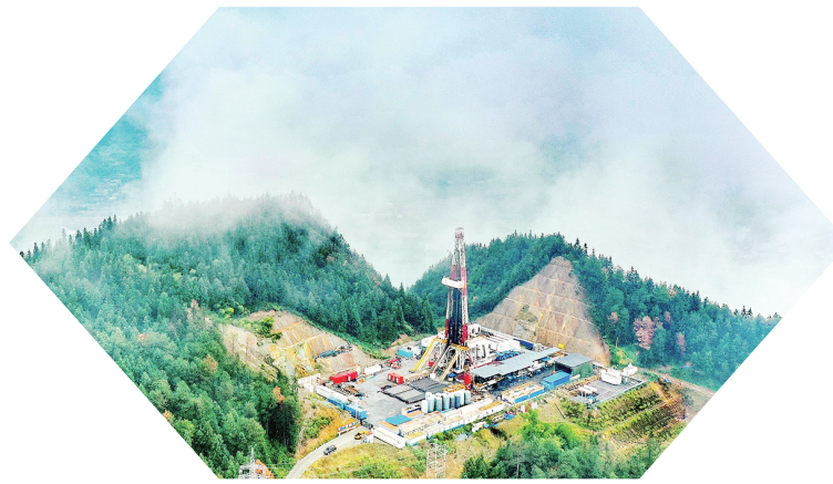
中国石化涪陵页岩气田阳页52钻井平台。
