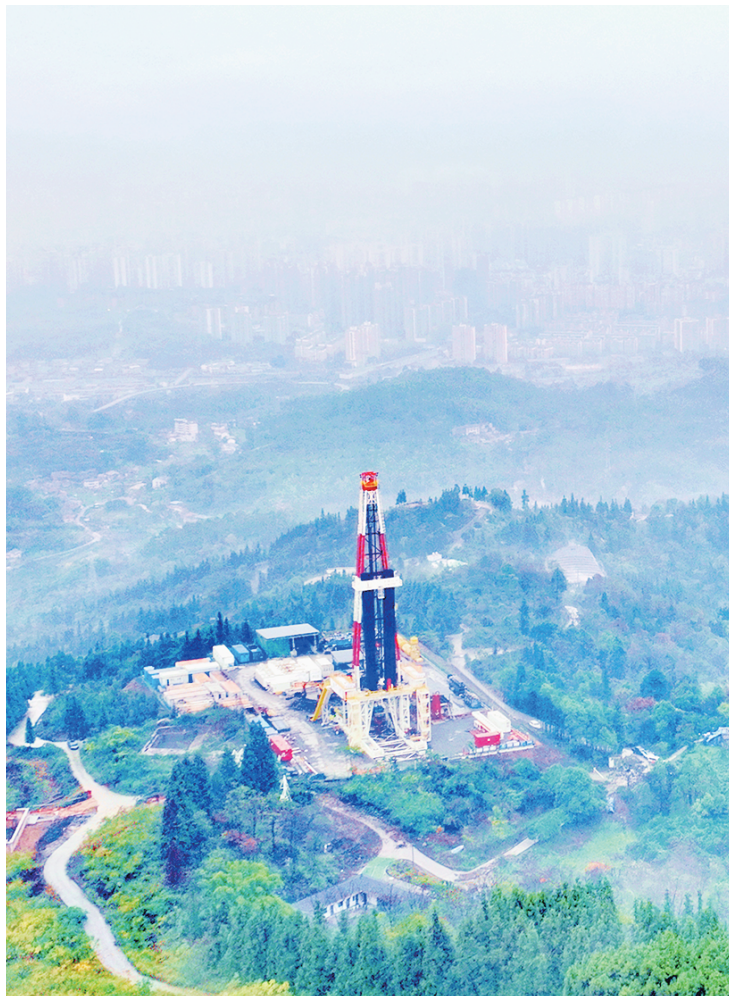
中国石化涪陵页岩气田阳页66-1HF井钻并现场。
