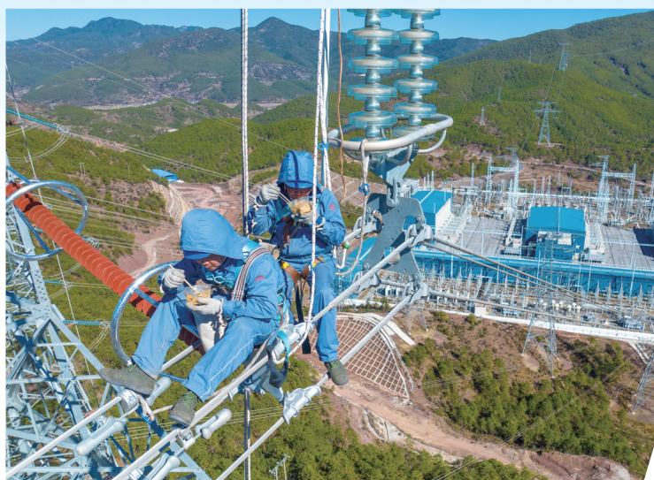
▲图为检修500千伏苗新乙线(苗尾电站至±800千伏新松换流站)期间,工作人员在216号塔导线上吃午饭。
