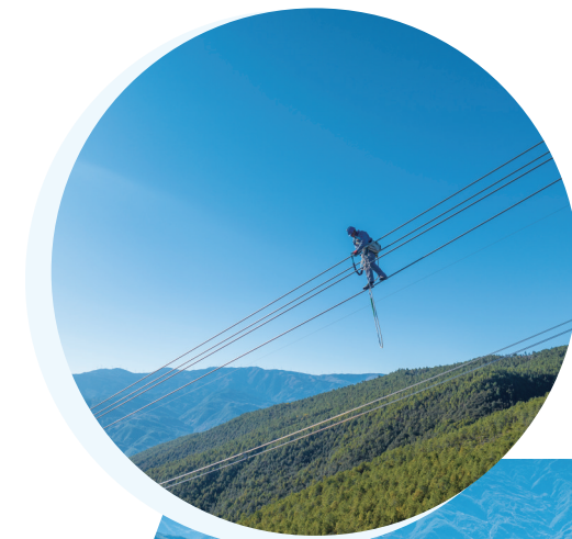
▲图为工作人员在位于大理白族自治州剑川县马登镇郊外的500千伏苗新乙线上走线检查导线及附件安全隐患。
