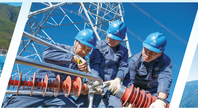
▲图为500千伏苗新甲乙线180号塔下,工作人员在氧化锌避雷器安装前,对避雷器部件连接螺栓紧固情况再次检查。
