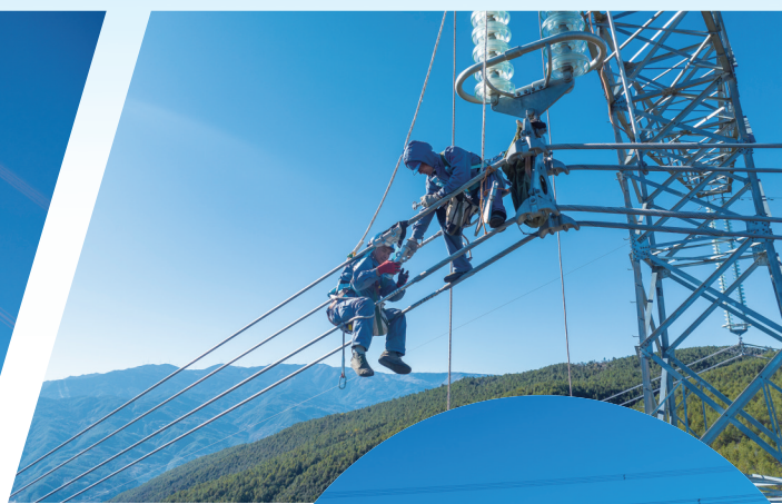
▲图为工作人员在大理白族自治州剑川县境内的500千伏苗新乙线216号塔上开展避雷器安装前准备工作。
