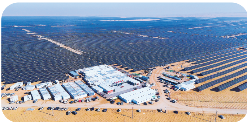
华能库布其新能源基地先导工程全貌。
