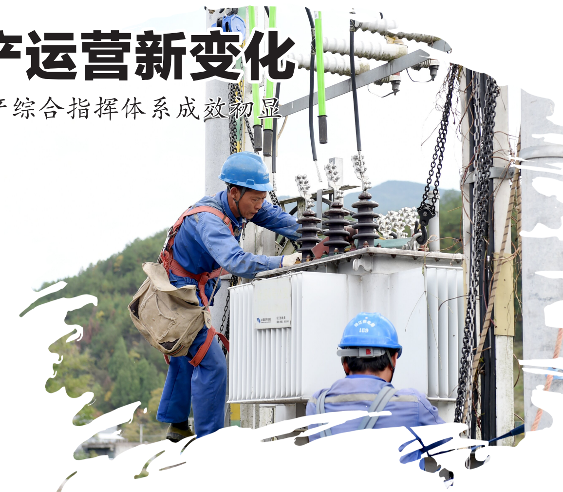
贵州电网公司铜仁印江供电局开展变压器增容,确保冬季用电稳定。 陈举/摄
