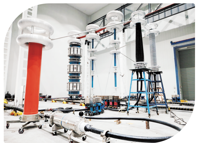
图为基于国产导电炭黑屏蔽料的220kV三芯交联聚乙烯绝缘海缆(含软接头)型式试验回路。南网科研院/供图
