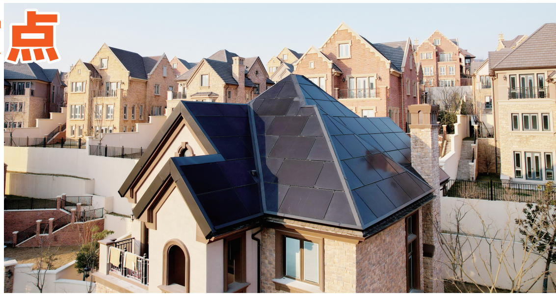
图为江苏南京使用爱旭N型ABC组件的屋顶。爱旭/供图
