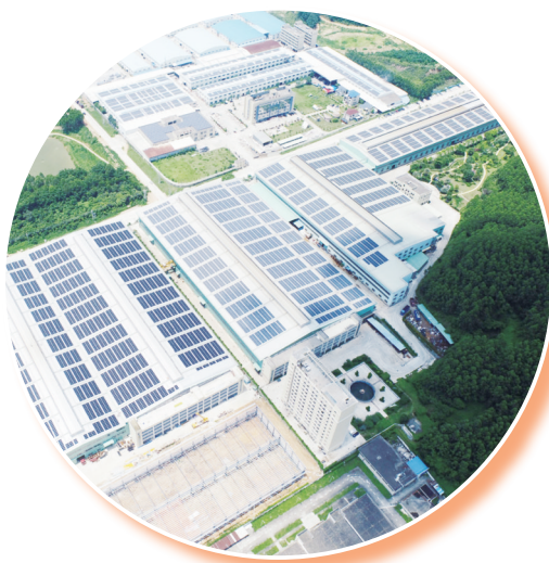
HPBC产品在广东博盈特焊技术股份有限公司厂房上的应用。隆基/供图
