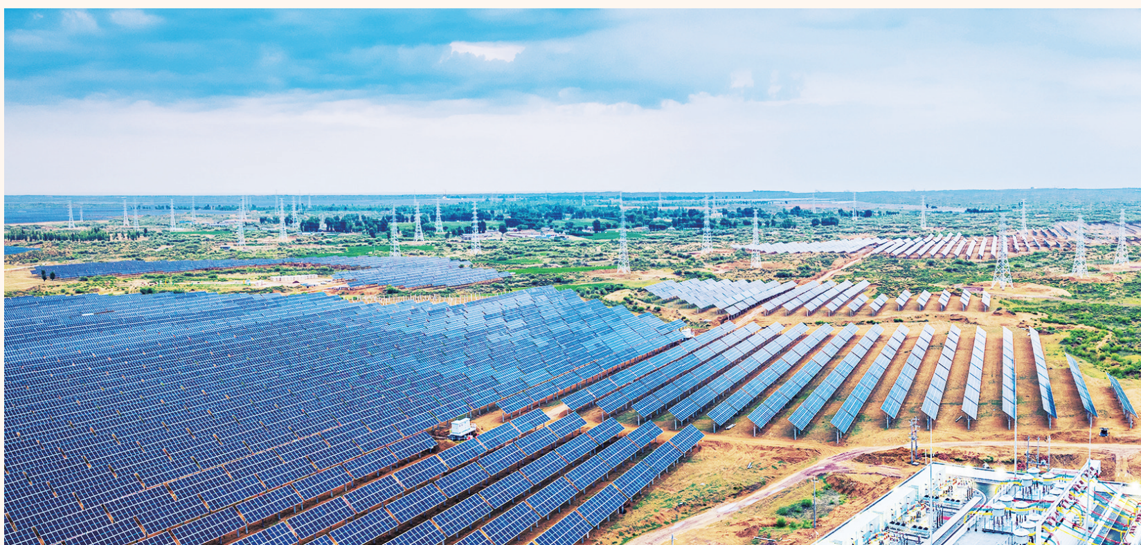
南瑞集团助力陕西榆林1000MW光伏项目建设。南瑞集团/供图
