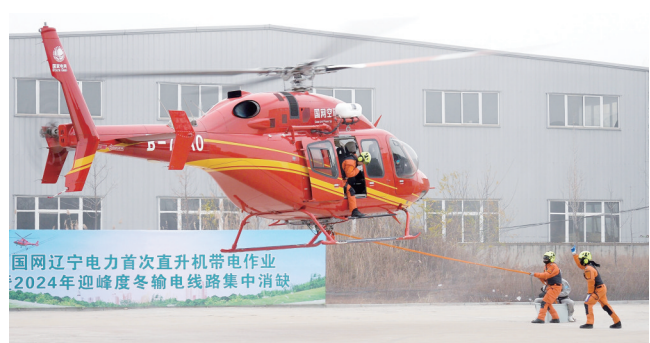
国网辽宁电力首次直升机带电作业,2024年迎峰度冬输电线路集中消缺。 于兴润/摄
